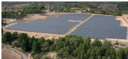
■ Solární park Bovera (Španělsko) firmy WIRSOL AG. Použito 20 km kabelů ÖLFLEX® SOLAR
